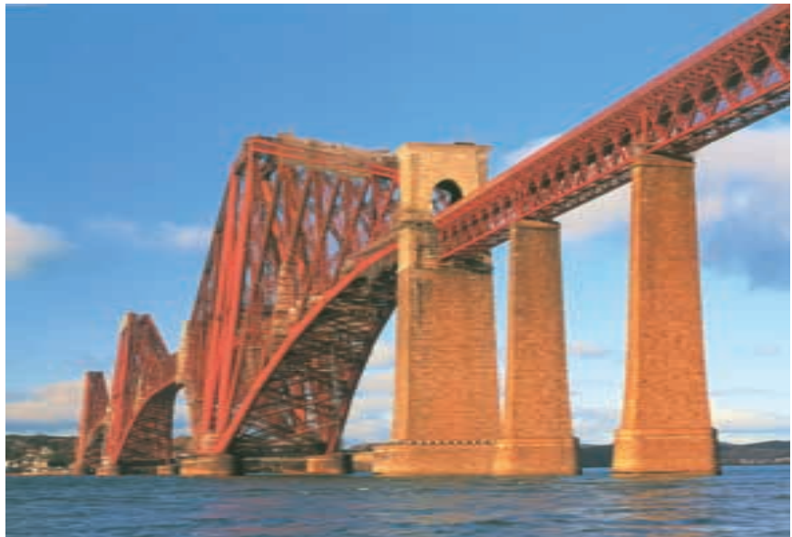
Brücke über den Firth of Forth, bei Edinburgh, 1890
