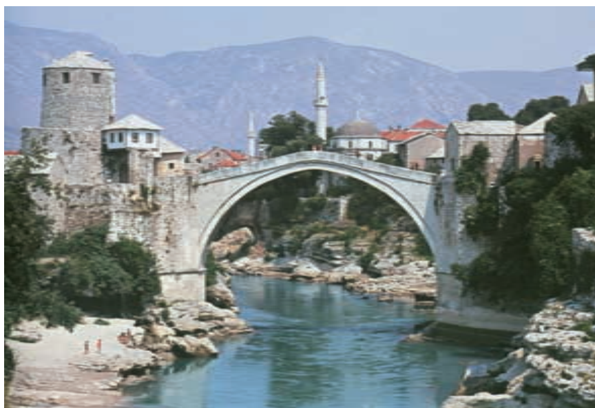
Brücke über die Neretva, Mostar, 1557
